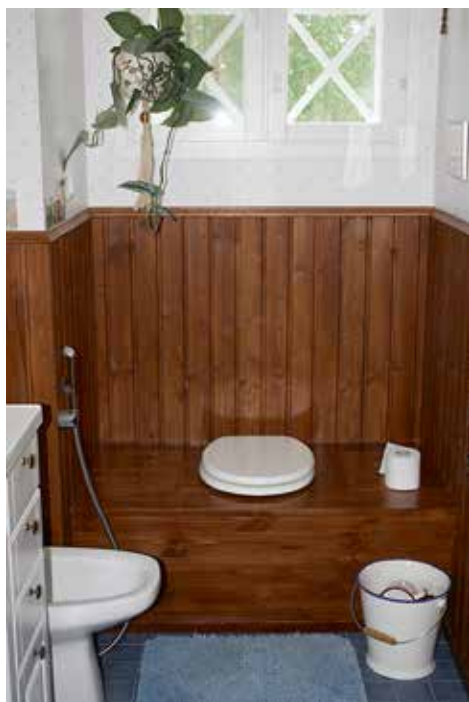
Kuivakäymälän voi rakentaa myös nykyaikaisesti vakituiseen asunnon sisälle. Vasemmalla posliini- nen bideallas.
