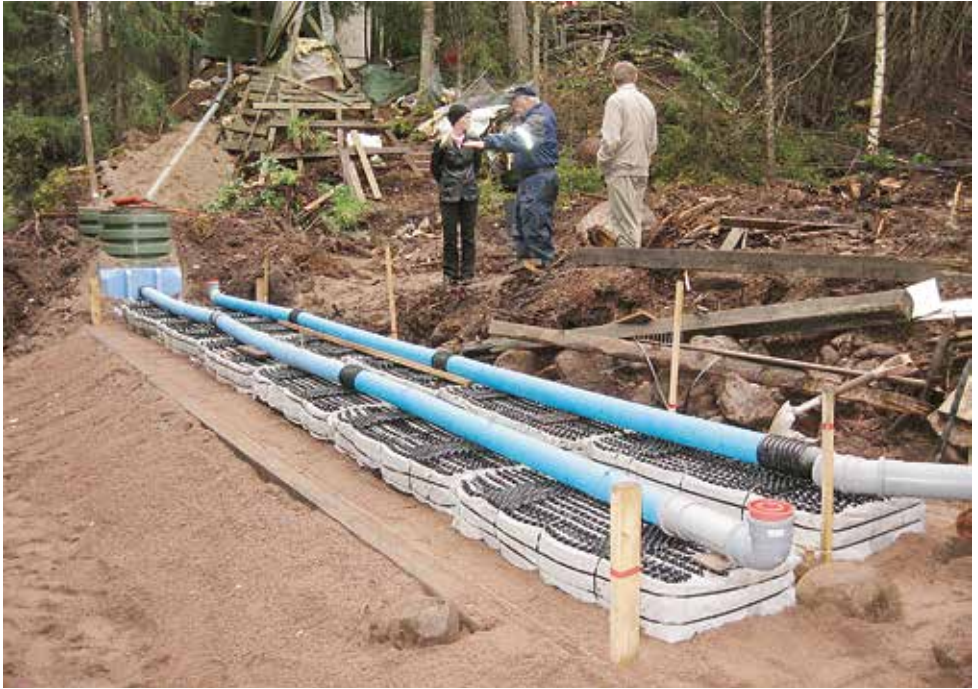
Moduulimaasuodattimen rakennustyömaa. Sinisten imeytysputkien alapuolella ovat moduulit ja niiden alla suodatinhiekkakerros.
