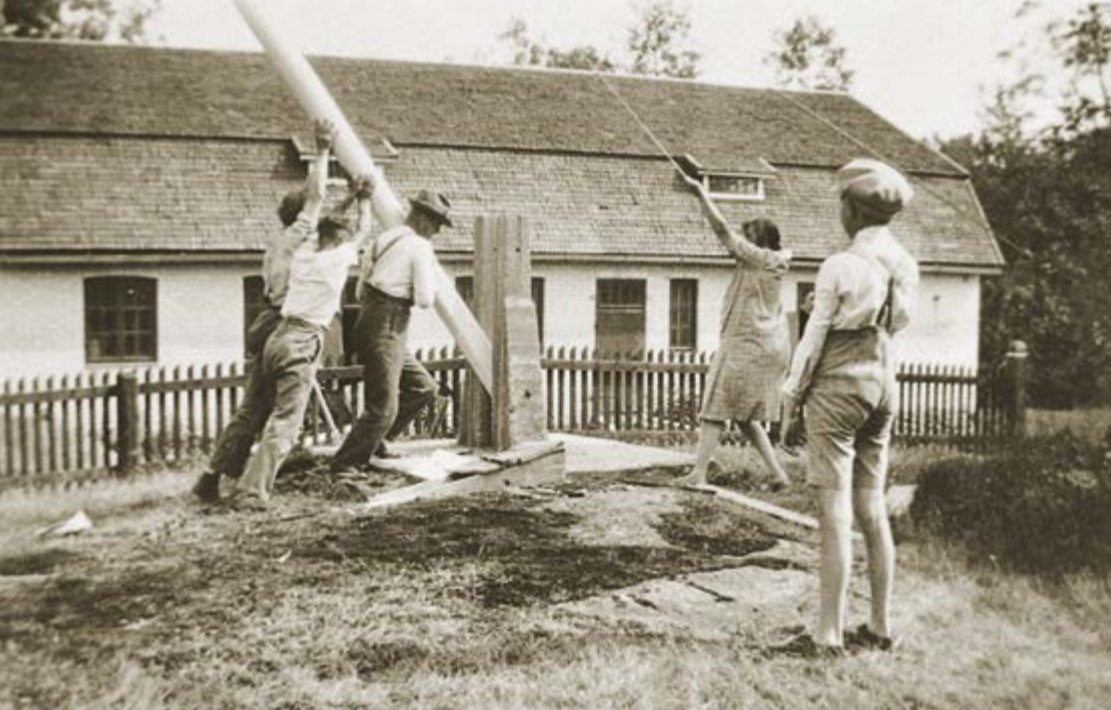
Väinö Saarion lipputankoa pystytetään Vähätalon pihalle vuonna 1930. Narusta vetämässä Ylitalon emäntä Eeva Pajunen (o.s. Vuorinen). Taustalla näkyy Vähätalon vuonna 1925 rakennettu navetta. Kuva TMK/Kaks kertaseura.
